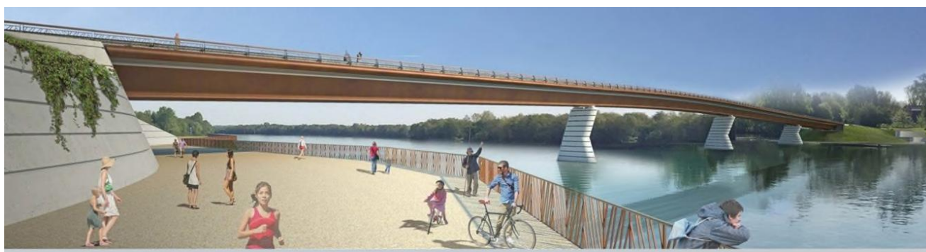
Figure 29 : Insertion architecturale et paysagère en 3D d'un caisson mixte acier/béton à hauteur constante- Fleurville @Ritz Architecture
