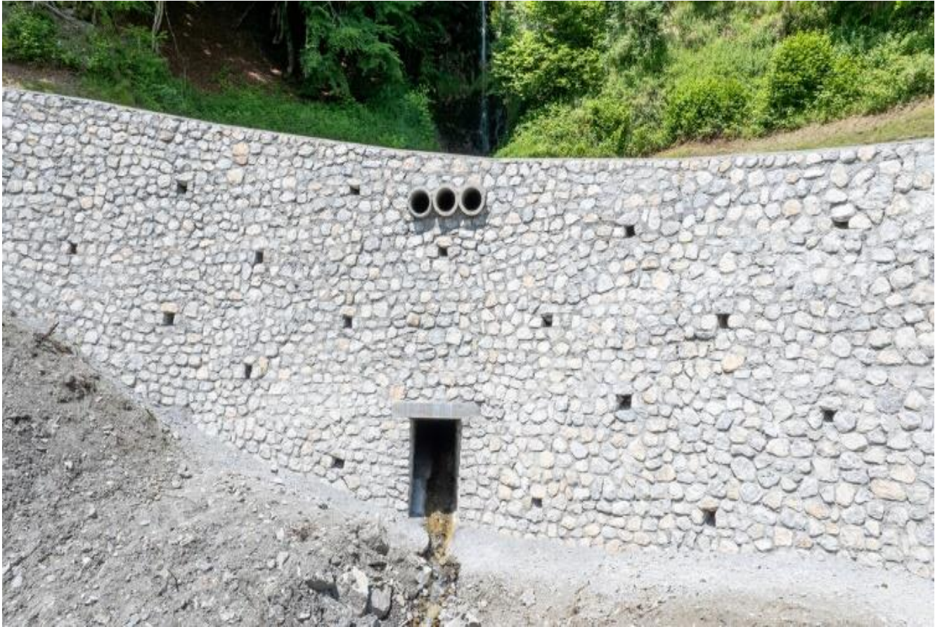
2024 Artigues RD 918 Mur de soutènement (virage des boulangers)
