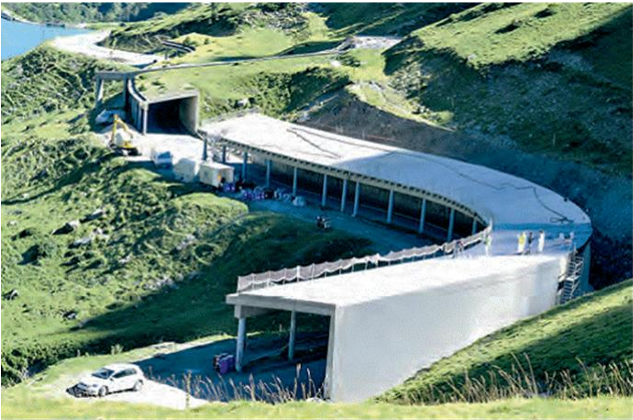
La Mongie RD 918 Réparation du paravalanche 510 000 € TTC
