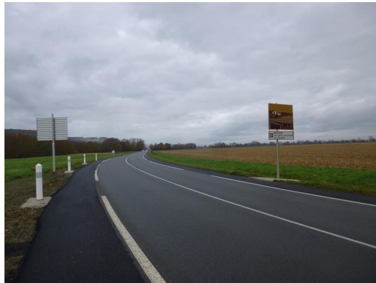
2024 Sombrun RD 935 accotements revêtus
