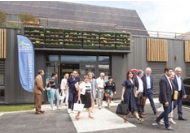
Construction de la nouvelle Maison Départementale de Solidarité à Bagnères-de-Bigorre, un bâtiment à énergie positive.
