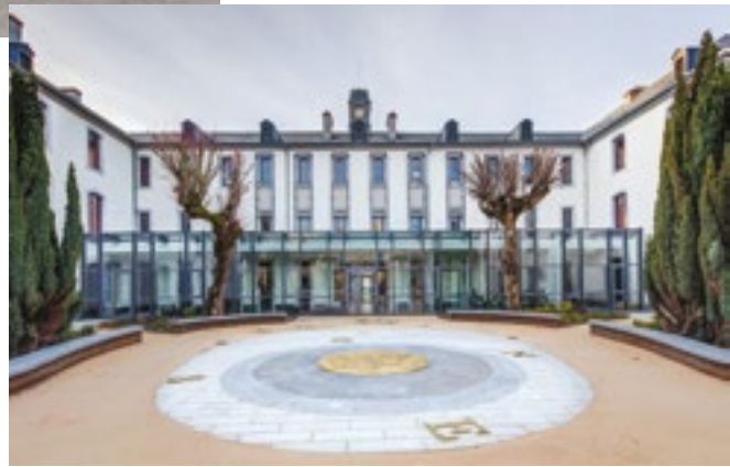
L'hôtel du Pradeau réhabilité
