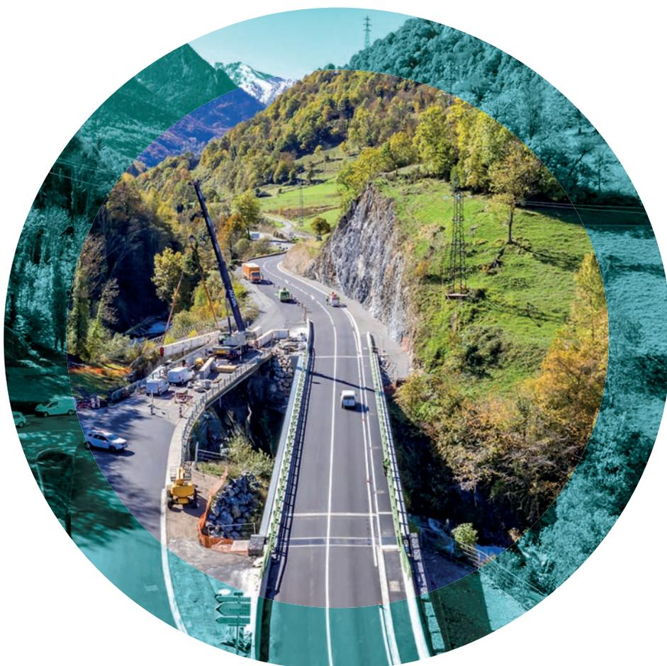
(glissement majeur à l'échelle européenne), l'ouvrage neuf a fait l'objet d'une conception spécifique et innovante permettant à l'appui en rive droite de la Neste de se déplacer tout en maintenant le tablier en place. Des dispositifs spécifiques ont été conçus afin de rendre possible ces opérations.
