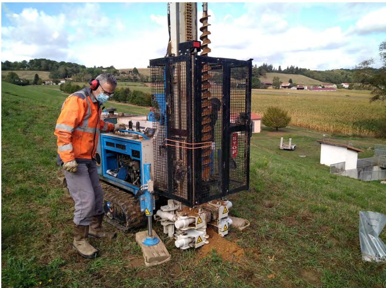
Figure 1 : Forage d'un piézomètre
