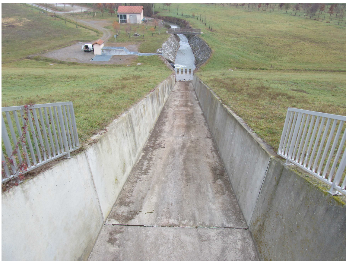
Évacuateur de crues du barrage du Magnoac (Décembre 2016)
