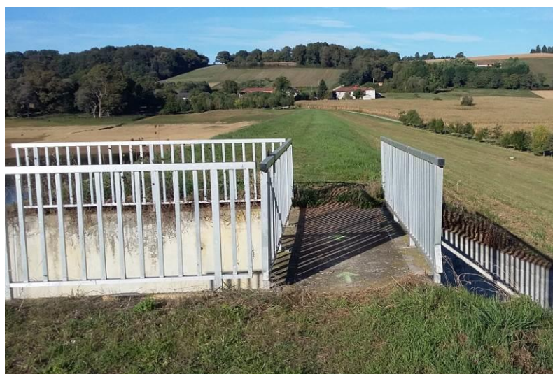
Passerelle EVC en crête
