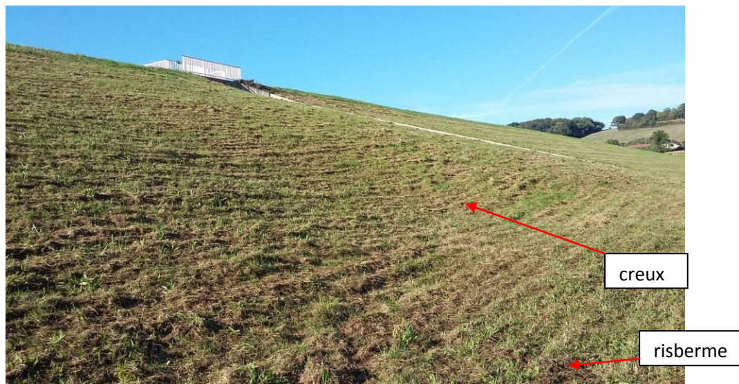
Parement sur le secteur concerné par ce « creux » - Vue depuis la risberme
