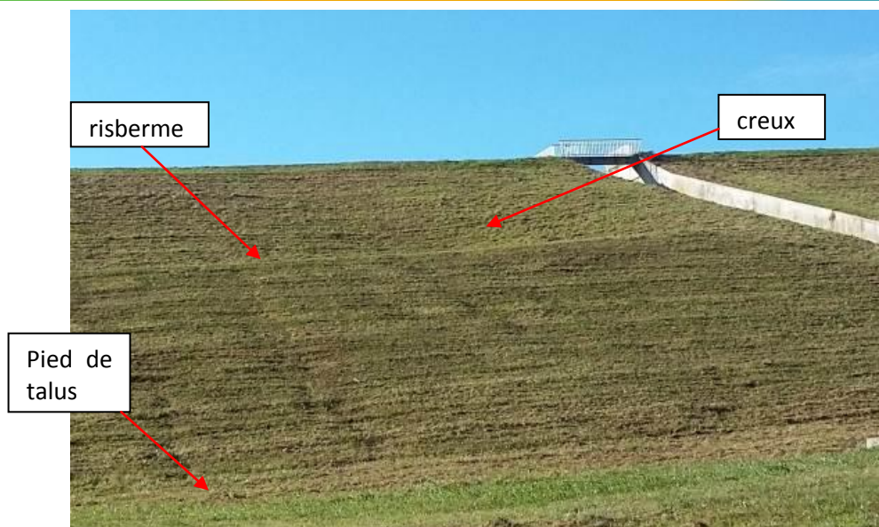
Parement aval sur le secteur concerné par ce « creux » - Vue depuis le bas
