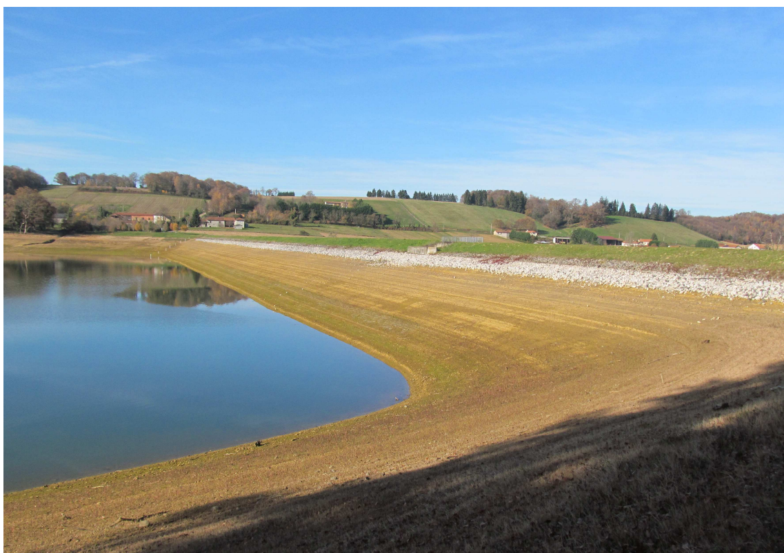
Parement amont du lac du Lizon
