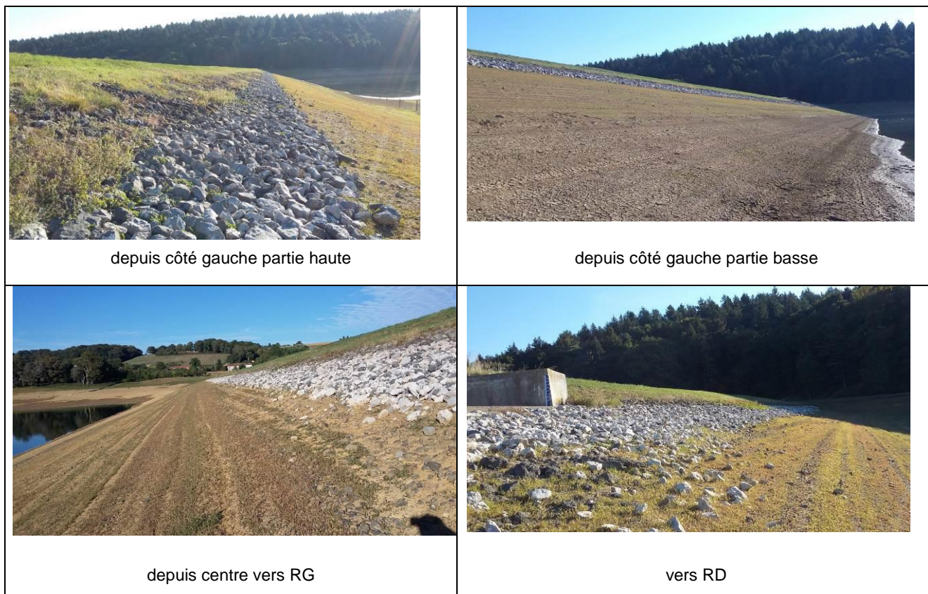
Vue du parement amont
