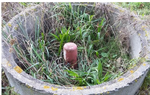
Exemple d'un piézomètre (Pz2)
