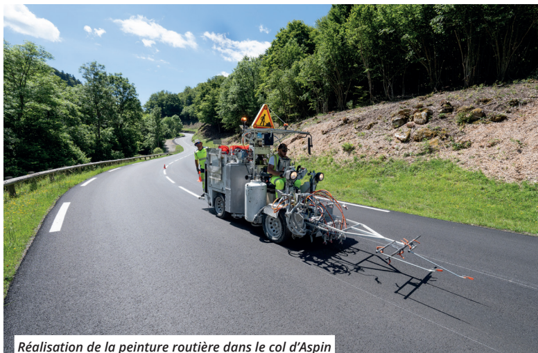
Réalisation de la peinture routière dans le col d'Aspin
